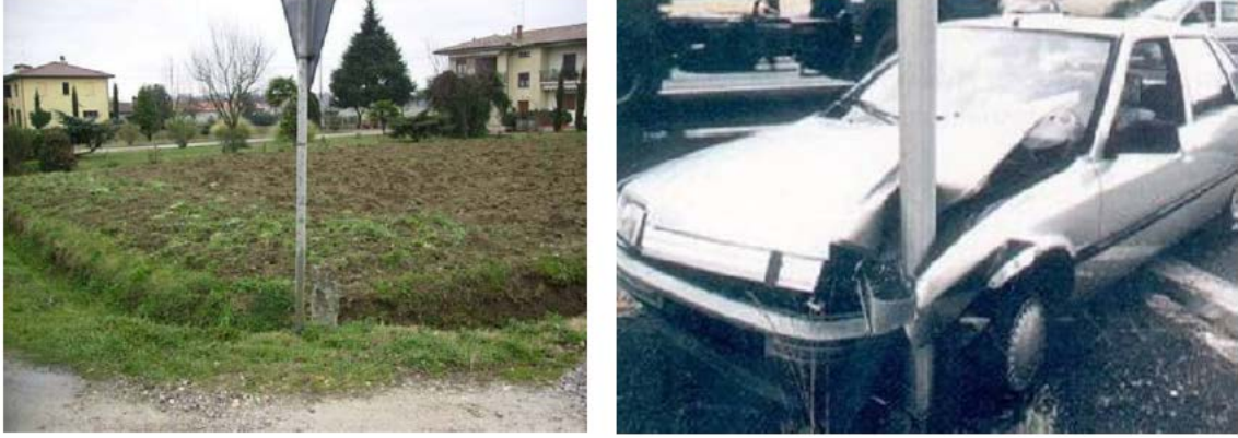
Şekil 51: Tehlikeli işaret direklerinin örnekleri (Kaynak: [A.3])
