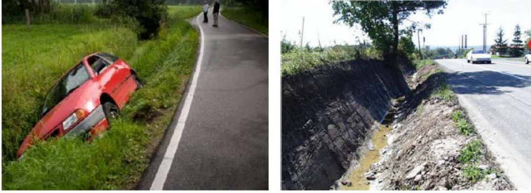
Şekil 57: Tehlikeli yol kenarı hendeği örnekleri (Kaynak: [A.26])
