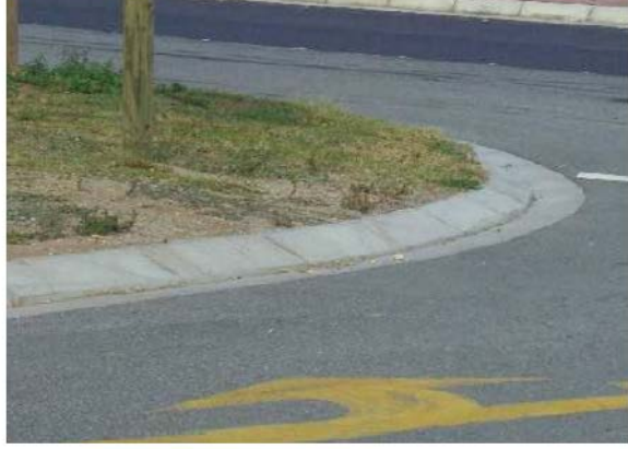
Şekil 73: Düsey bordür (sol) ve eğimli bordür (sağ)
