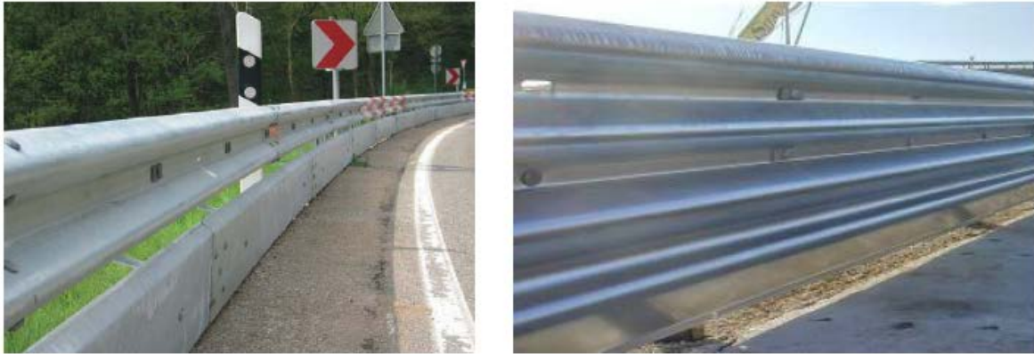
Şekil 80: Sürekli yüzeye olanak sağlayan motosikletliler için bariyer sistemi örnekleri (Kaynak:[A.38])
