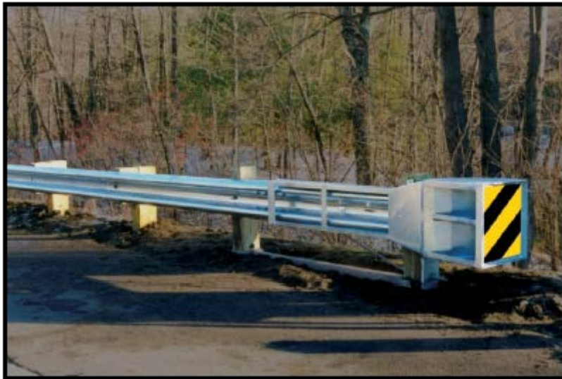
Şekil 11: Ortabatı tescilsiz enerji sönmleyen sonlandırıcı
