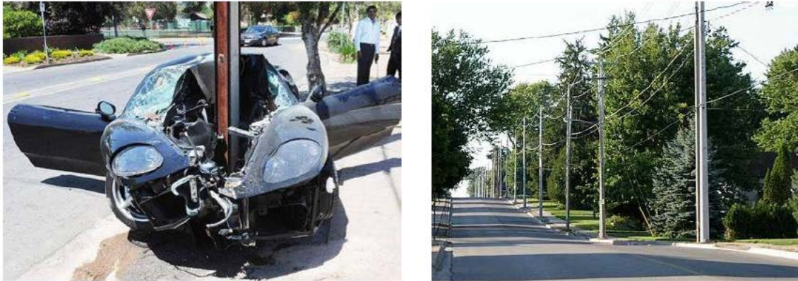
Şekil 50: Tehlikeli telefon/elektrik direklerinin iki örneği (Kaynak: [A.51])
