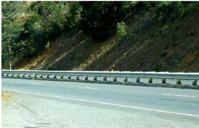
Şekil 78: Tipik W-kırıslı orta refüj yerleştirmesi [A.40]
