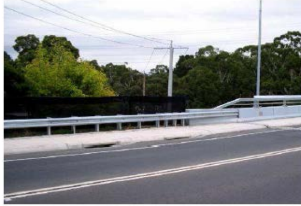
Şekil 75: Yarı-rijit ve rijit bariyer arasındaki geçiş [A.40]
