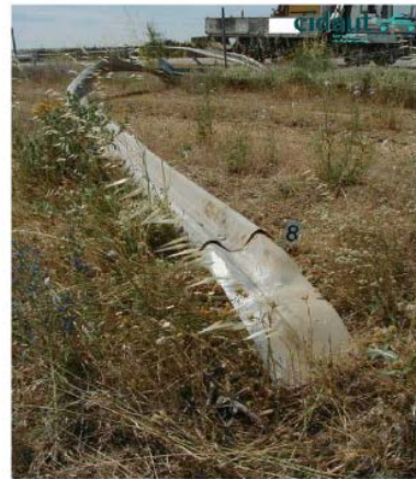
Şekil 14: Sonlandırıcının ilk birkaç dikmesine çarpılmasının sonuçları
