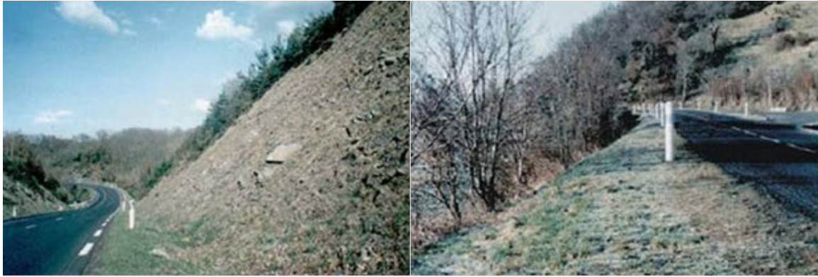
Şekil 56: Tehlikeli yarma (sol) ve dolgu sevi (sağ) örnekleri (Kaynak:[A.2])
