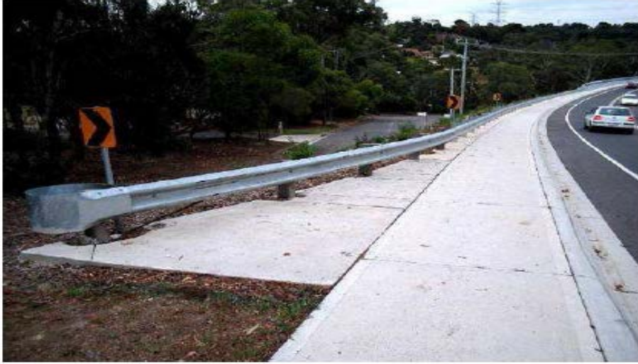
Şekil 4: Yatay olarak kaydırılmış sonlandırıcı [9]
