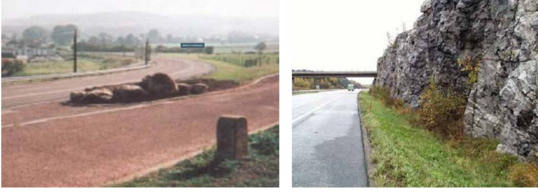
Şekil 54: Yol kenarındaki tehlikeli kaya kütleleri (sol) ve kayaların (sağ) örnekleri (Kaynak:[A.2] ve [A.3])
