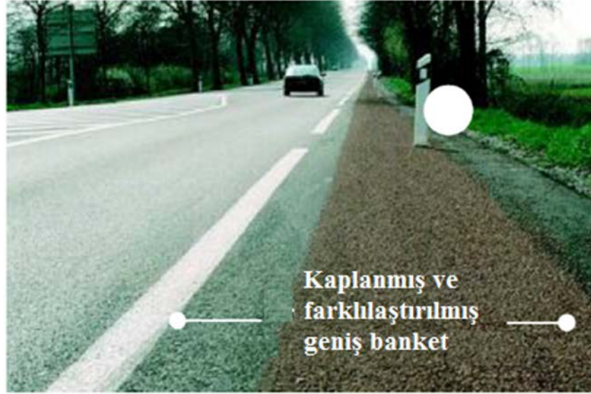
Şekil 41: Sürücülerin geniş banketlere bağlı güvenlik algısını azaltmak için farklı renkler kullanma
